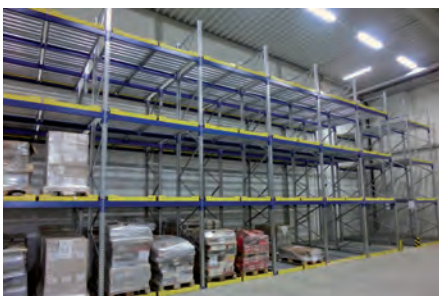
Zwaartekrachtrollenbanen – te gebruiken op de onderste etage en in de vaketages
